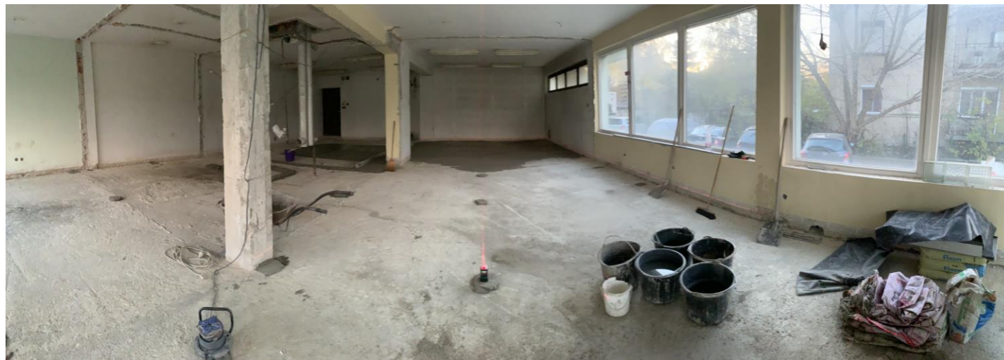
Szerkezetkész állapotra bontás után
