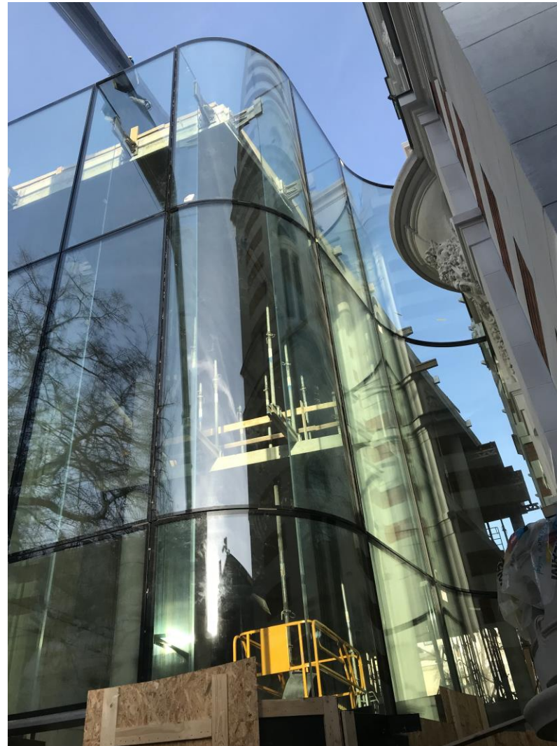
A homlokzat építés közben
