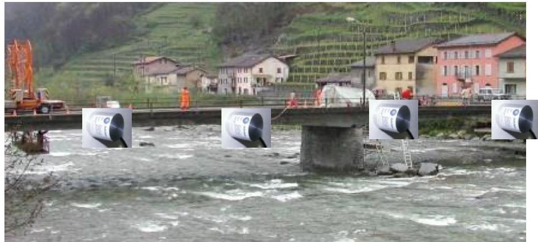
akusztikus kibocsátás mérése, kábelszakadás detektálására
