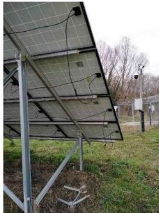
Sérült, lógó kábelek
