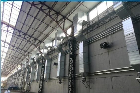
Műhelyek, látszó légtechnikai rendszerek – „trombitacsó” BIM gyártmányterv
