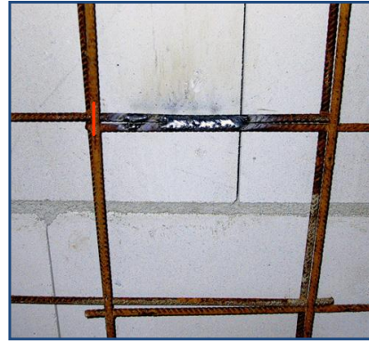
Hegesztési hely betonvasalás-háló
